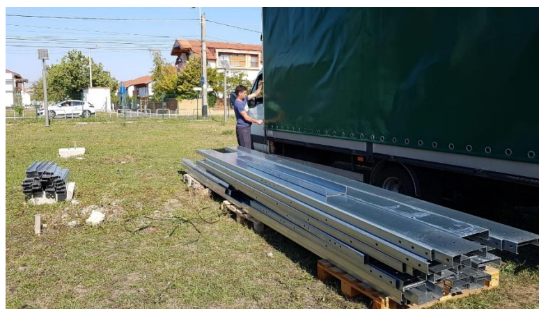
Figura 4.2. Recepționarea elementelor structurale pe șantier
